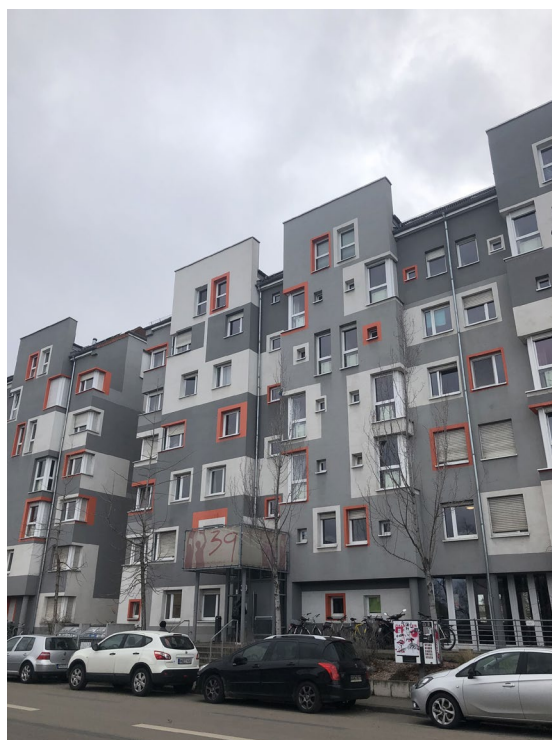
※ Hafenstraße 宿舍外部
